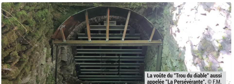
L'entrée a été réparée à Saint-Joseph. © F.M.
